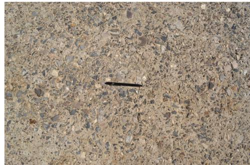
FOTO ESEMPIO - finitura piano di calpestio in cemento con inerti di piccola e grossa granulometria bene amalgamati nell'impasto
